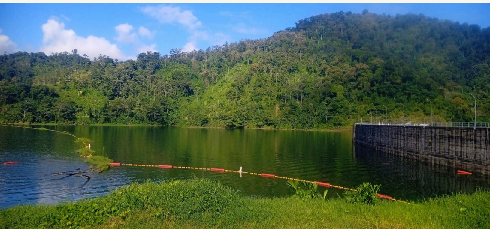
Muro de la represa-Corte Culebra
