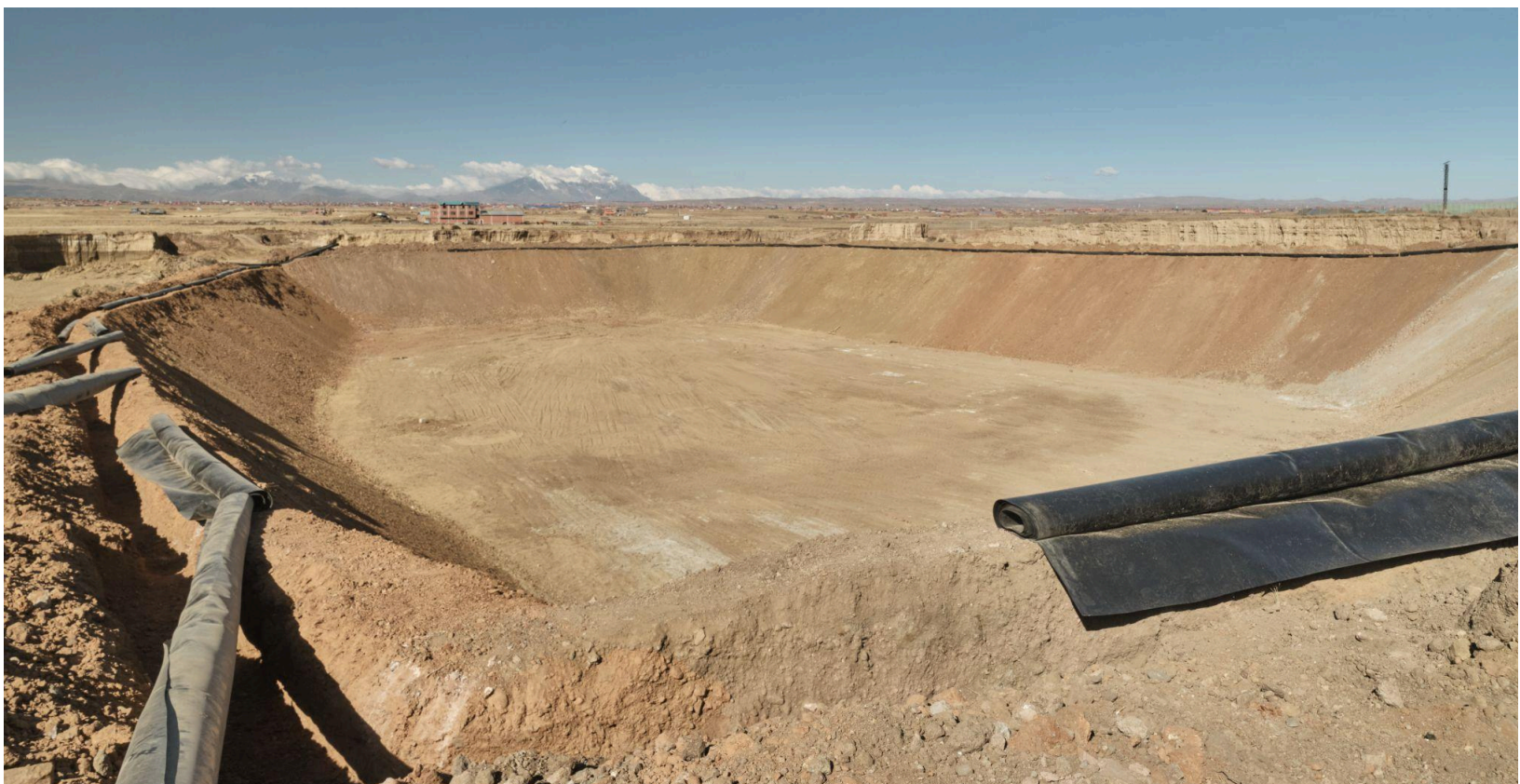
Dique de colas improvisado, hecho de un día para el otro, para almacenar los desechos tóxicos en la comunidad Seque Jahuira. Foto por Julien Defourny.
