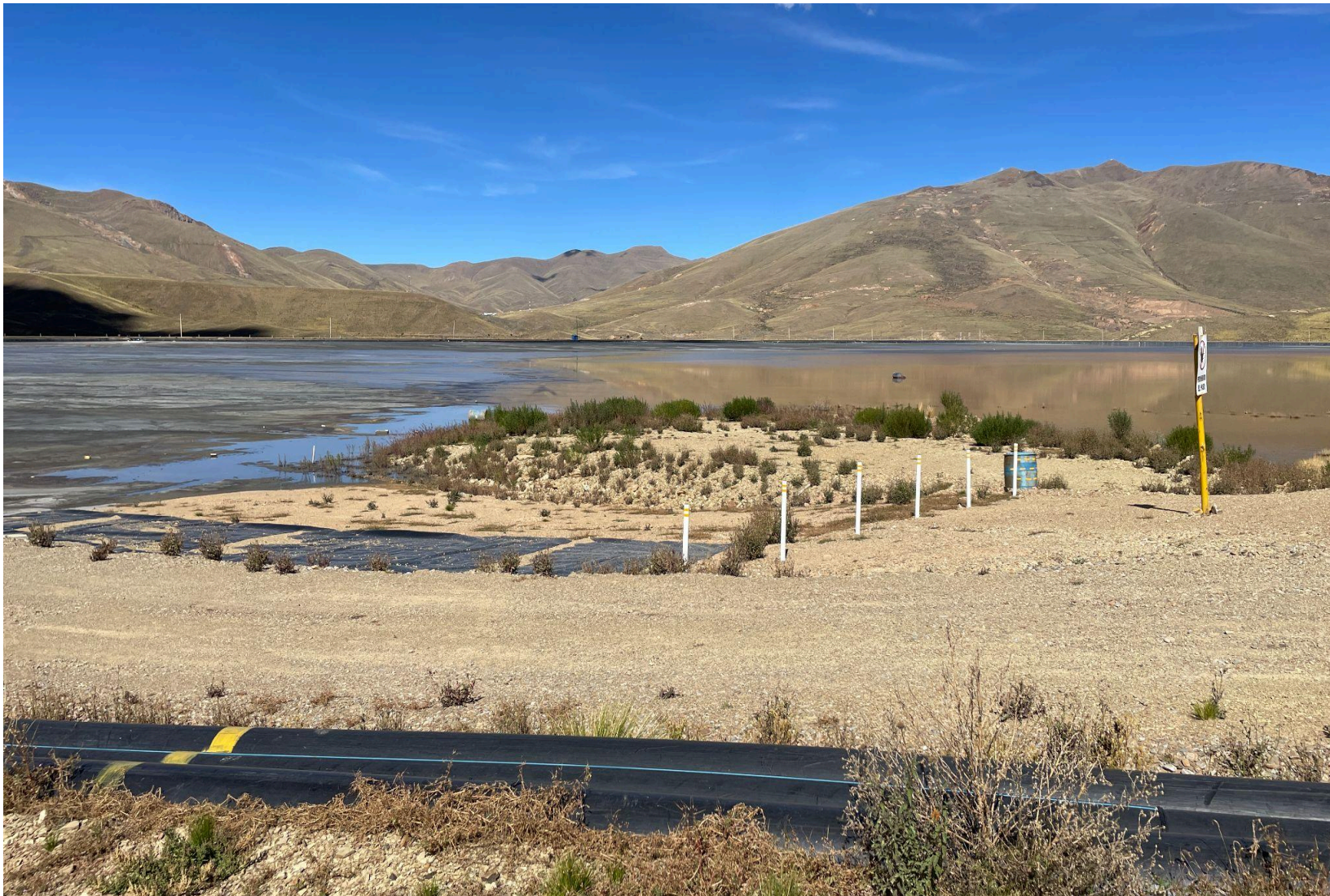
Dique de relaves lleno de agua contaminada en Queyaqueyani Grande. Foto por personal de Cultural Survival.
